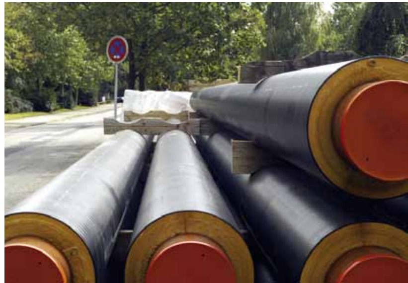
Die neuen, gut isolierten Fernwärmerohre kurz vor der Verlegung
